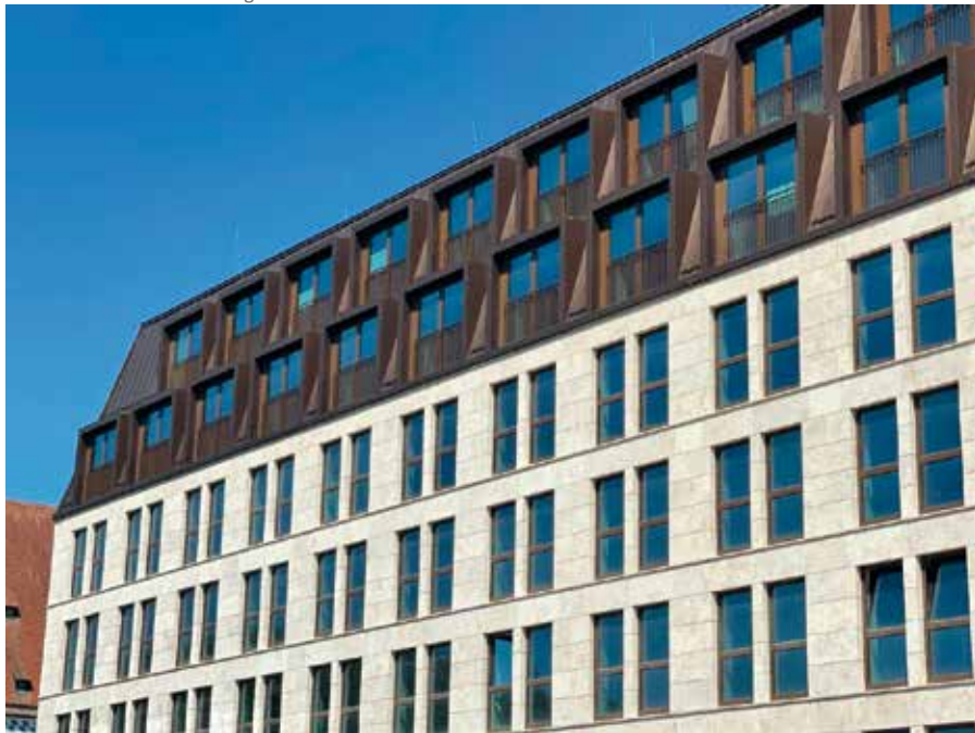
Neubau Hotel und Congress Centrum Ingolstadt
