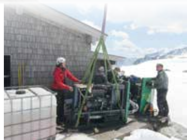
Das alte und neue Blockheizkraftwerk im Austausch
